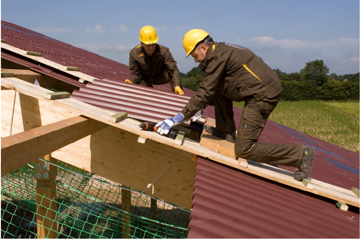
Dacharbeit mit Sicherung
