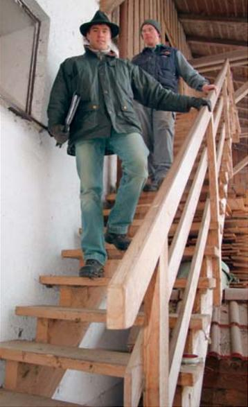
Absturzkrisiko und Verletzungsgefahr sind bei unsachgemäßer Verwendung von Leitern besonders groß. Ersetzen Sie - wo immer möglich - Leitern durch Treppen.
