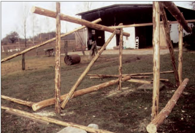
Nachdem 2 Seitenteile fertig montiert sind, werden sie seitlich aufgerichtet und mit Latten bzw. Stangen abgestützt. Mit Hilfe der rechtwinklig gespannten Schnur (s. Seite 17) werden auch diese Seitenteile ausgerichtet, sodass alle 4 Seiten des Bockgerüsts die gleiche Neigung haben. Danach können die Quer- und Diagonalstreben verschraubt werden. Bei Bockgerüsten
