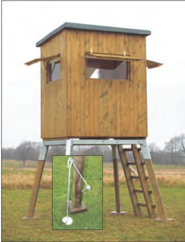
**Bockgerüst mit konischen Eckpfosten und Erdanker**
