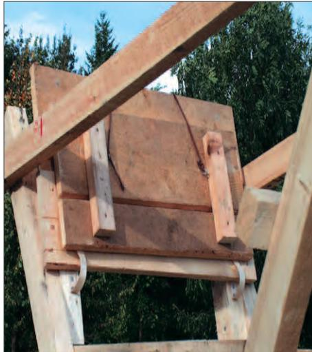
15. Um eine große Durchstiegsöffnung zu erreichen, muss das Sitzbrett so weit wie möglich hochgeklappt und arretiert werden. Zuerst wird mittig im oberen Viertel der Rückenlehne ein Nagel eingeschlagen und auf der Rückseite umgebogen. Durch den Schlüsselring wird ein Stück Rollladenband durchgezogen und am umgebogenen Nagel eingehängt. Danach wird das Sitzbrett dann so weit wie möglich angehoben und das Rollladenband auf der Unterseite des Sitzbrettes befestigt.
