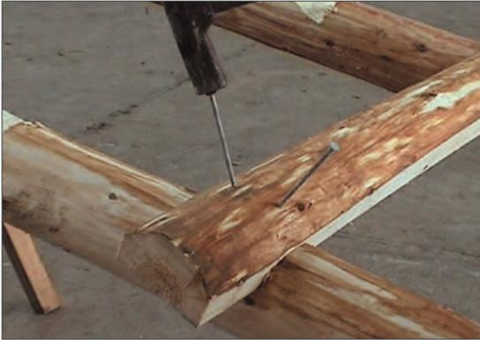
*Werden die Sprossen mit Nägeln befestigt, sind diese seitlich versetzt und schwalbenschwanzförmig einzuschlagen. Der Sprossenüberstand beträgt mindestens 60 mm, damit das Holz nicht aufreißt.*
