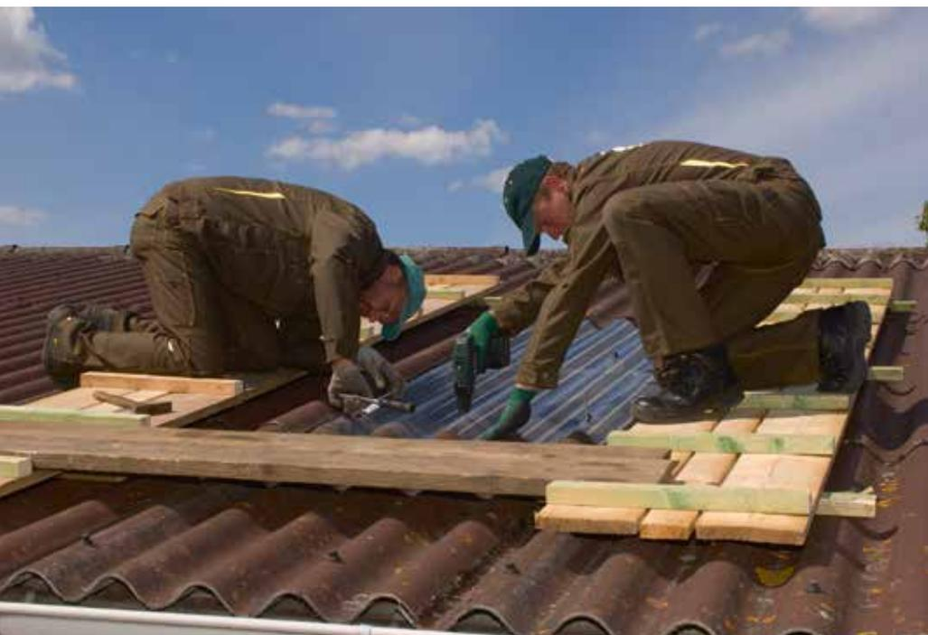
**Arbeiten auf Faserzementplatten dürfen nur auf lastverteilenden Belägen durchgeführt werden.**
