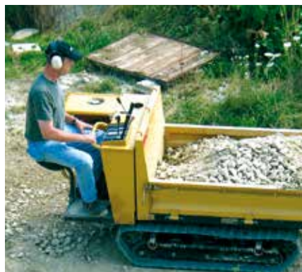
Gehörschutz bei Erdbauarbeiten
