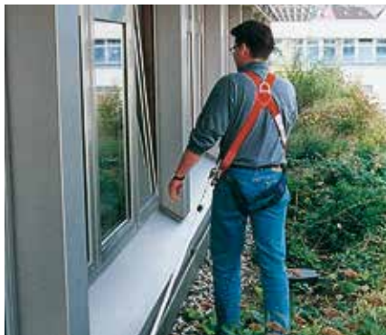
Absturzsicherung bei Dacharbeiten
