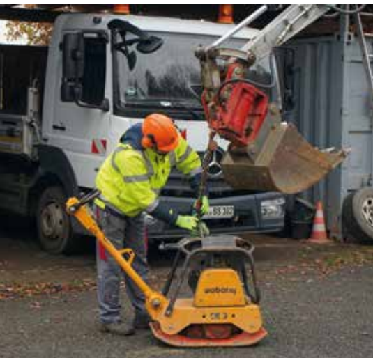
Einsatz eines Schutzhelmes bei Anschlagarbeiten.
