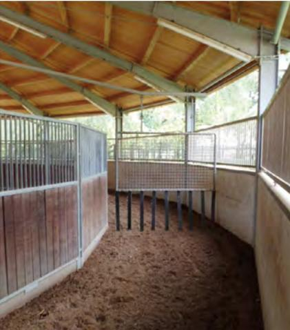
*Innenbereich der Führanlage mit sicherem Trennelement*
