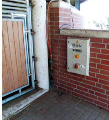
*Steuerungseinrichtung in unmittelbarer Nähe zur Führanlage*
