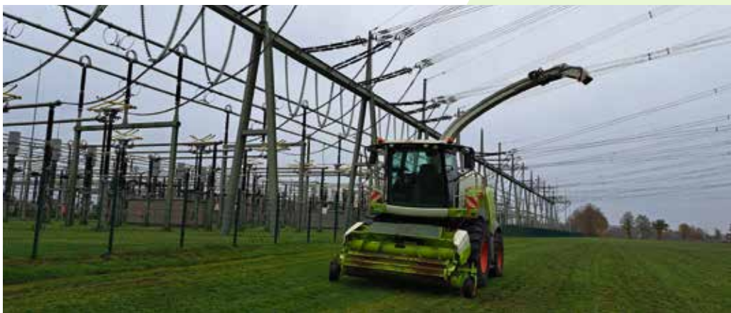
Bei Arbeiten unter oder im Umfeld von Freileitungen gilt vor allem eins: Auf Abstand achten!
